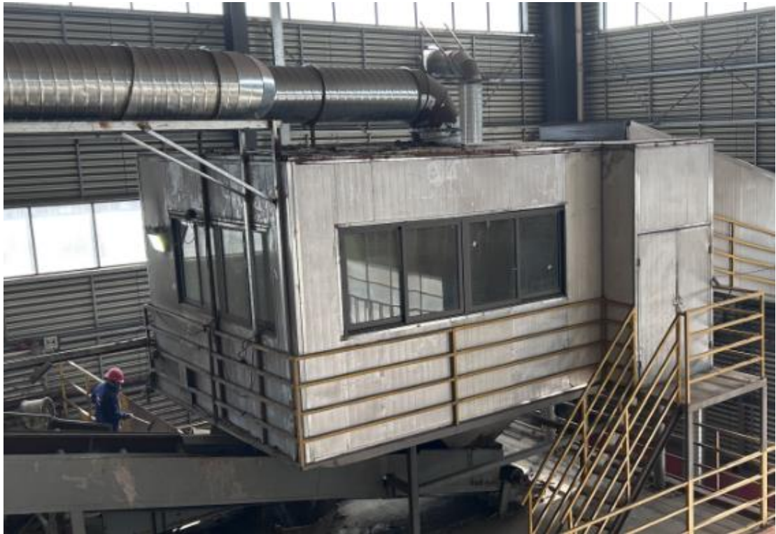
图 4-2 滚笼筛隔间废气收集现状
