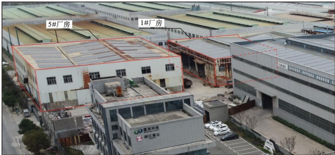
图 2-5 拟改造厂房现状外观
